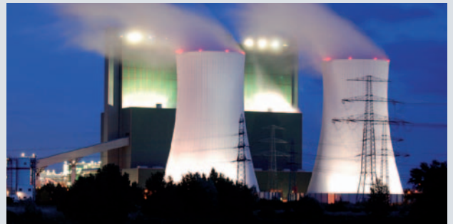
Centrales eléctricas, desulfuración de los gases de combustión.
