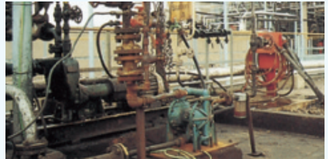
Bomba Blagdon 25 metálicas en una importante planta química en el noreste de Inglaterra.
