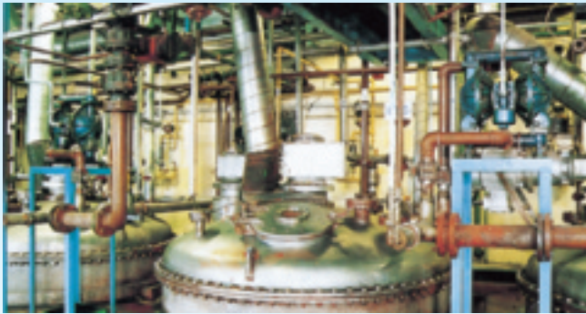
Bombas Blagdon 50 alimentando el circuito principal para la mezcla final en una planta de producción de pinturas.
