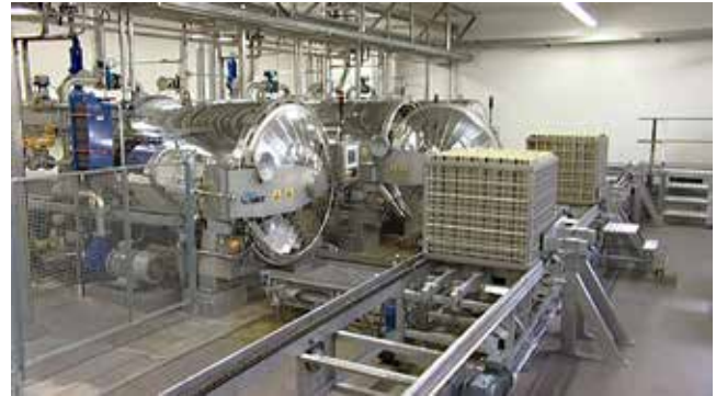
Sistema de transporte con transportadores fijos
