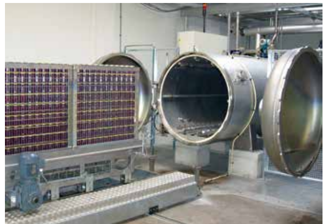
Sistema de transporte con transportador
