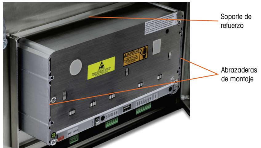
Figura 2-6: Soporte de refuerzo del panel instalado
